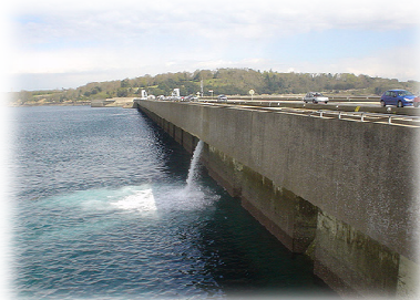
Barrage de l'usine de la Rance
