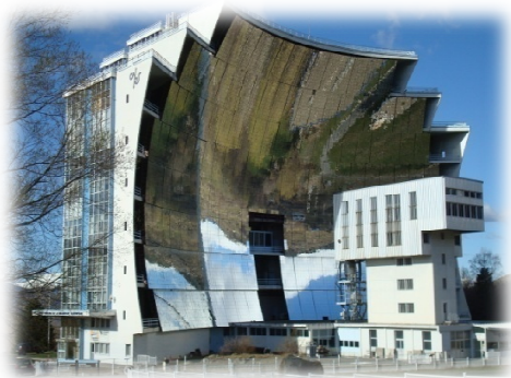
Grand Four solaire
