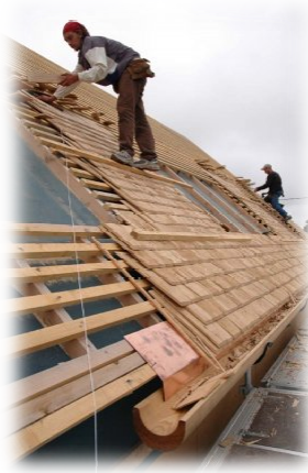
Exemple de chantier situé en Bretagne et réalisé en bardeaux de chêne.
